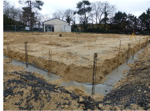
Photo 2 : Construction en cours
